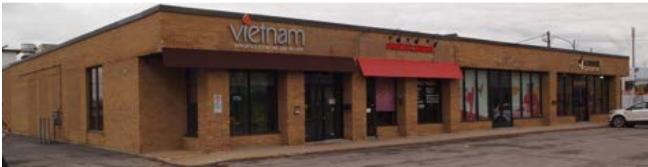
Fig. 52. Commerce de transit sur le boulevard de l'Industrie [Source : Provencher_Roy, 2019]
