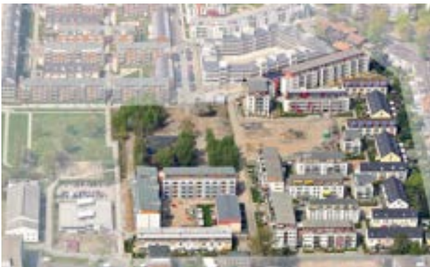
Vue aérienne lors de la construction (Source: Vivre à Stellwerk sans voiture)
