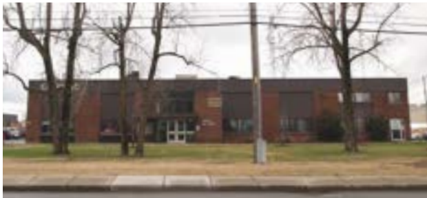
Fig. 39. Bâtiment institutionnel (Hôtel de Ville) de 2 étages (Source: Provencher_Roy, 2019)
