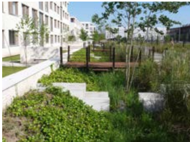
Fig. 161. Noue végétalisée permettant une rétention des eaux sur le site (Source : BruelDelmar).
