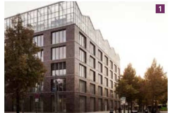
Fig. 225. [1] Centre administratif et serre de toit, Oberhausen, Allemagne. (Source : Hiepler Brunier).
