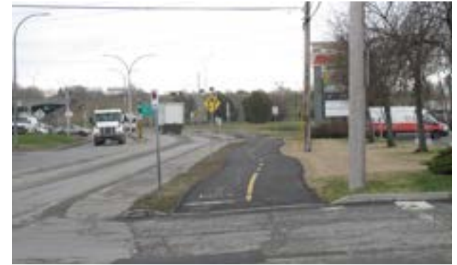
Fig. 80. Piste cyclable en site propre, située sur le boulevard Montcalm Nord au sud du Chemin Haendel [Source: Provencher_Roy, 2019]
