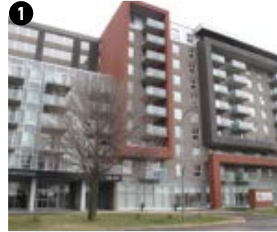
Fig. 60. Multilogement (Source : Provencher_Roy, 2019)
