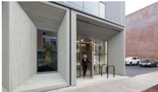
Fig. 155. Valorisation de l'entrée principale (Source : 12DEE).
