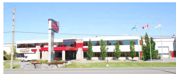
Bâtiment industriel (Fenplast)
