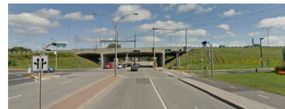
Boulevard Montcalm Nord. Traverse sous le viaduc de l'autoroute 15. Effort physique et psychologique pour le piéton : longue intersection, achalandage des voitures Source : Google Maps — © 2013 Google
