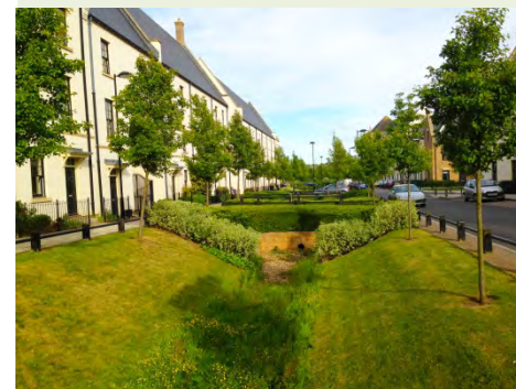
Bassin de rétention, Upton Meadow, Northampton, Angleterre
