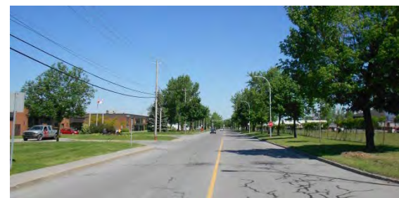
Trottoir sur un côté de la rue et rue rectiligne favorisant la vitesse, boulevard Montcalm Nord
