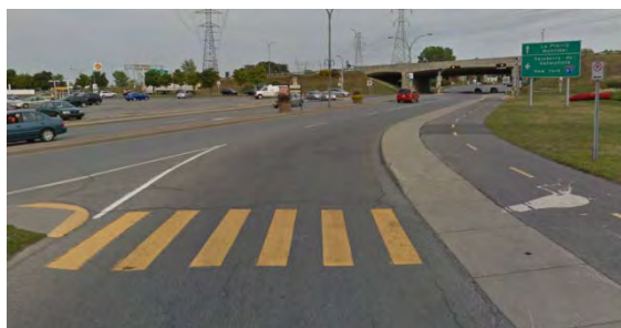
Traverse de piéton sur la bretelle d'accès du chemin Haendel vers le boulevard Montcalm Source : Google Maps — © 2013 Google
