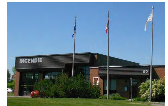
Bâtiment municipal – caserne de pompiers
