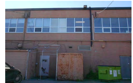
Cours arrière du centre commercial, donnant sur le futur terminus d'autobus – stationnement, entreposage, conteneurs à déchet
